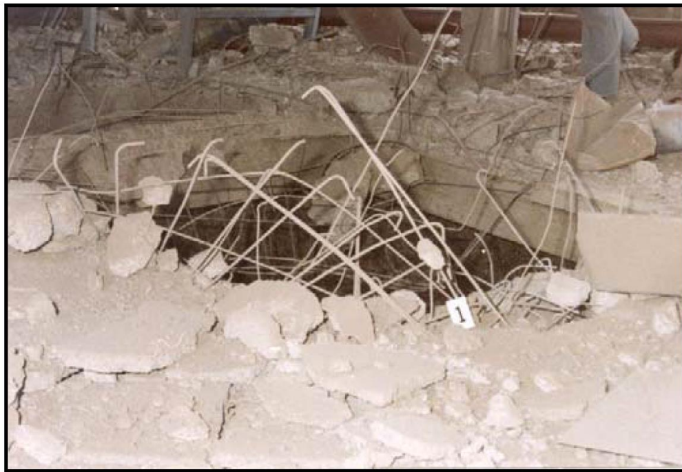
Slike 3 i 4: Silosi tvrtke Agroprerada d.d. , u Ivanić-Gradu, 14. srpnja 2006. g. i izgled mjesta eksplozijskog (prema učinku – detonacijskog) proboja gornje armiranobetonske deke silosne jedinice br. 26.
