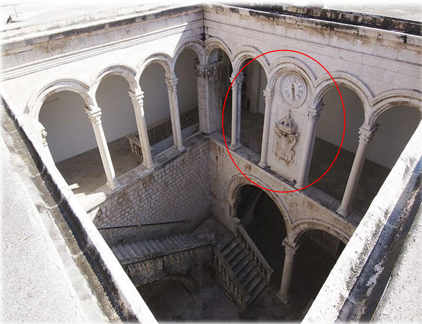
POGLED NA ISTOČNO PROČELJE U ATRIJU
