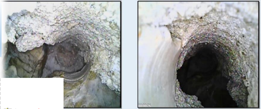
VIDEO ENDOSKOPSKI NALAZ NAKON INJEKTIRANJA TEMELJA
