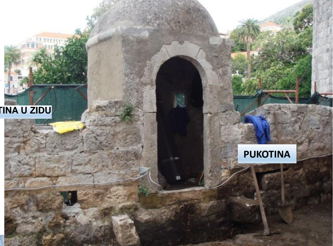
NAGNUTE KAMENE KONZOLE KOJE PODUPIRU STRAŽARNICU
