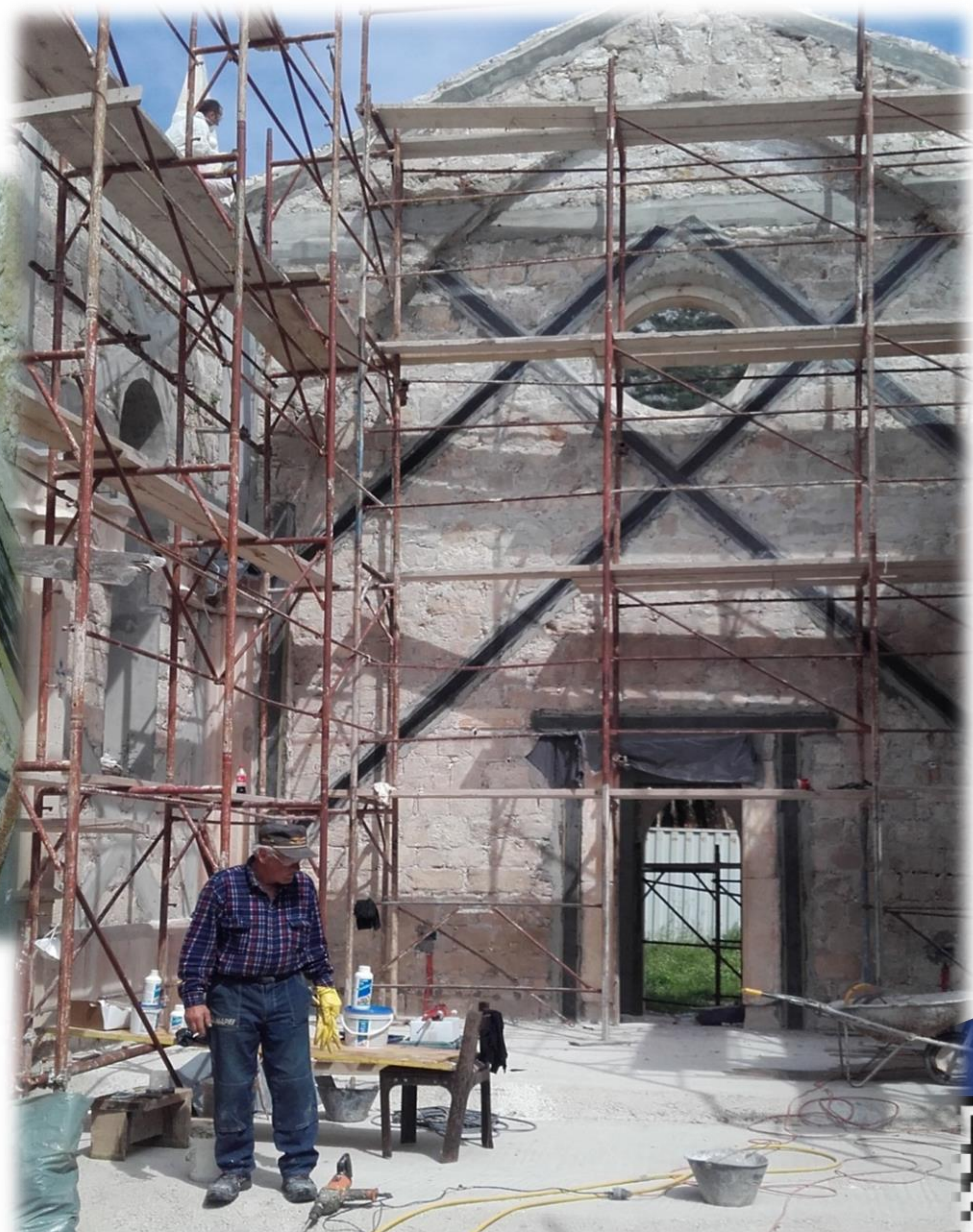
UGRADNJA KARBONSKIH TRAKA
