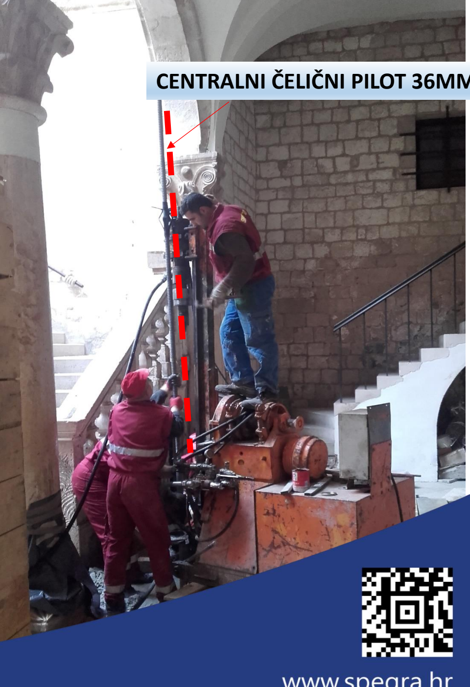
IZVOĐENJE TEMELJNIH PILOTA
