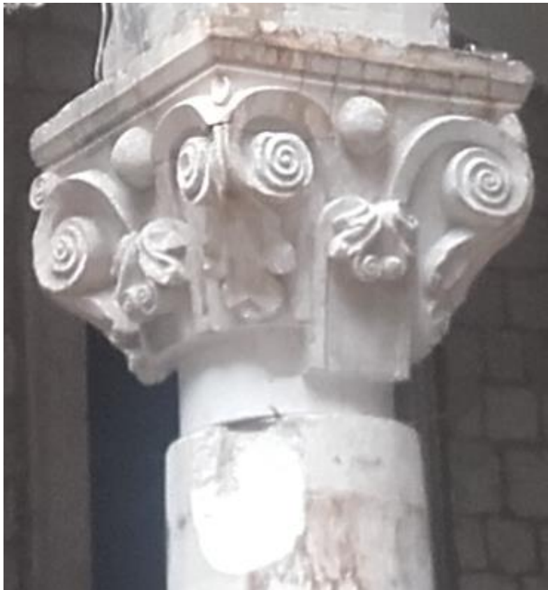
Kapitel stupa: stanje prije završne faze sanacije
