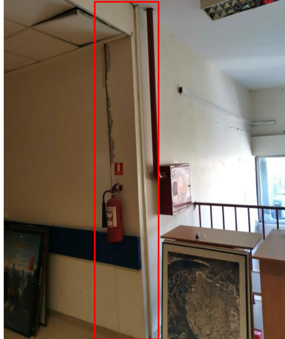
Prikaz pozicije odvajanja spoja dvaju ortogonalnih zidova. Pozicija spoja krila.
