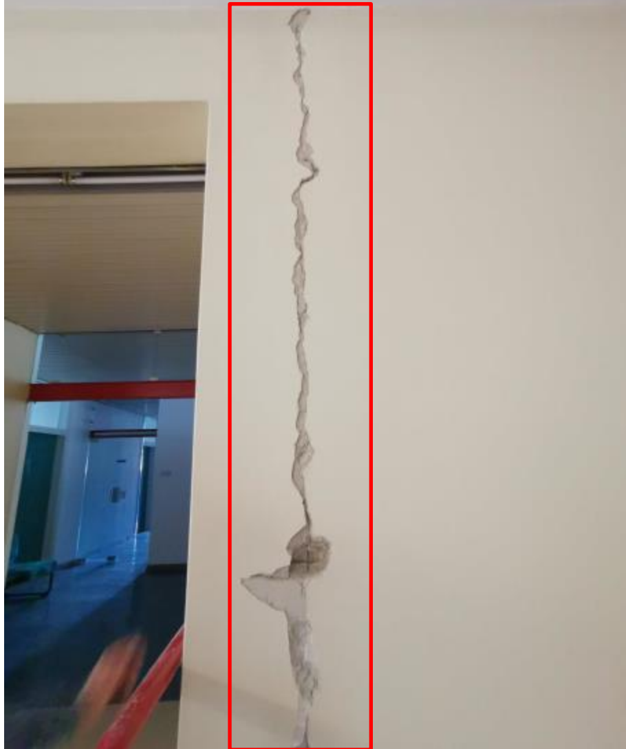
Prikaz pozicije odvajanja spoja dvaju ortogonalnih zidova. Pozicija spoja krila.
